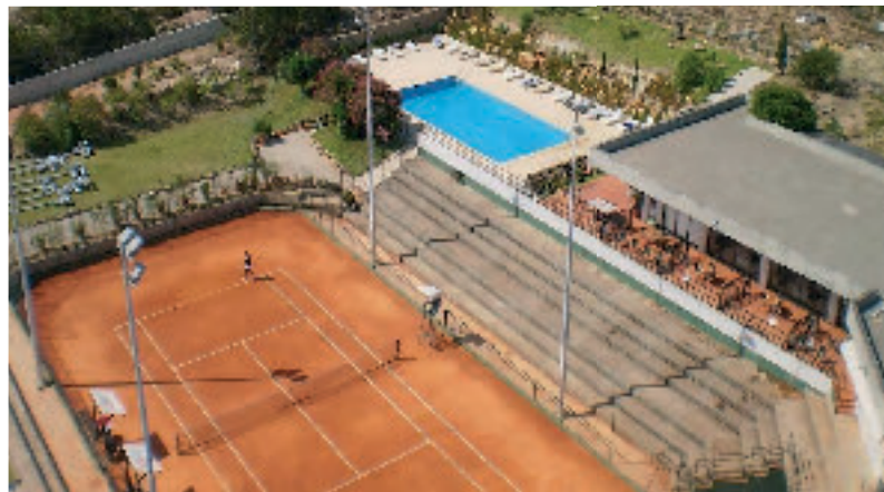
Construção da nova sede do Clube, 1991 | AHMCS/AASS/CTE
