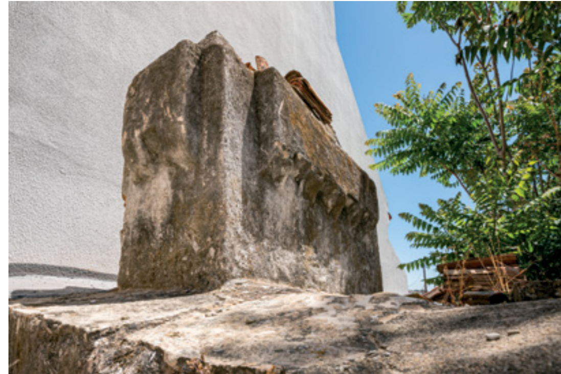
Aspetto de chaminé de forno de uma antiga habitação saloia, Rua da Galiza, 2023 [AHMCSC/AFTG/CFC/004/003/010]
