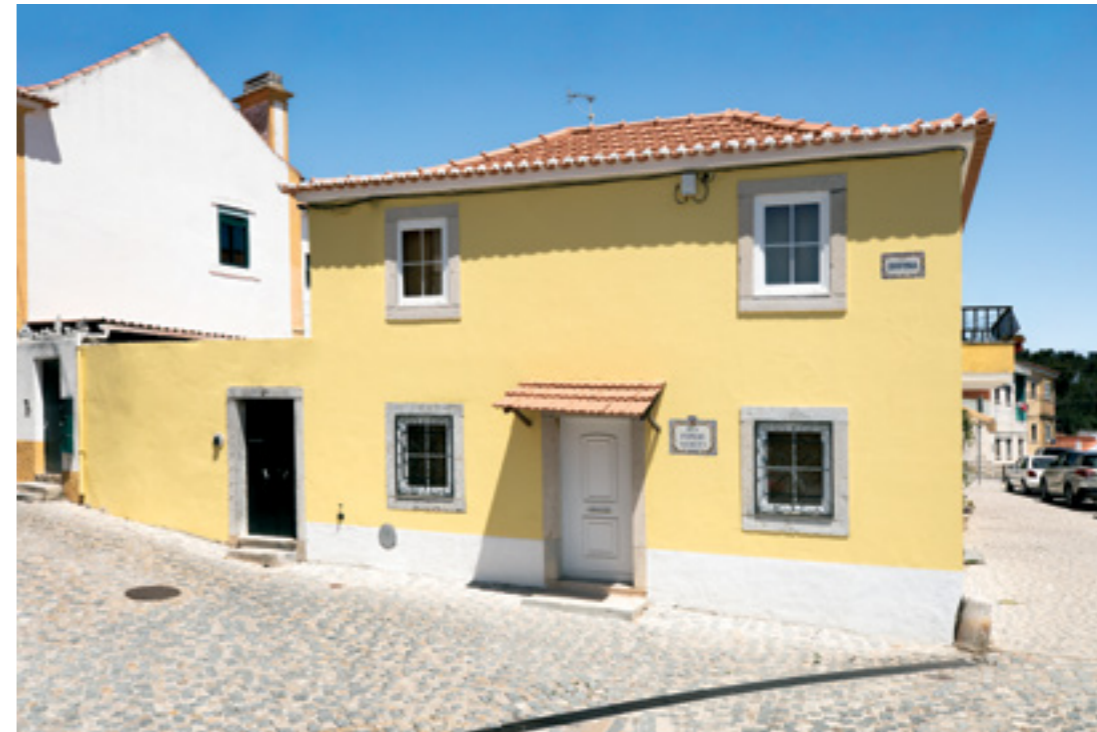
Casa de dois pisos, adaptada a contexto urbano. Portão de acesso a pátio com vãos de pedra. Argola em ferro para amarração de animais no exterior de casa - Vivenda Quirina, Rua Fernão Vasques, 2023 [AHMCSC/AFTG/CFC/004/003/007, 008 e 009]
